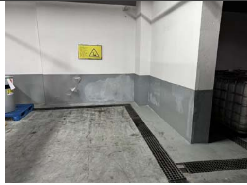
地面硬化及设置收集沟
