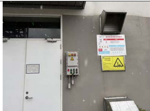
危险废物贮存设施标识牌
