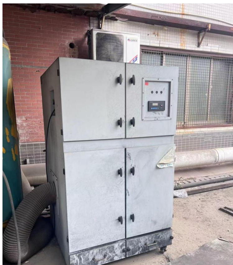
设备维修（修磨）1套除尘装置
