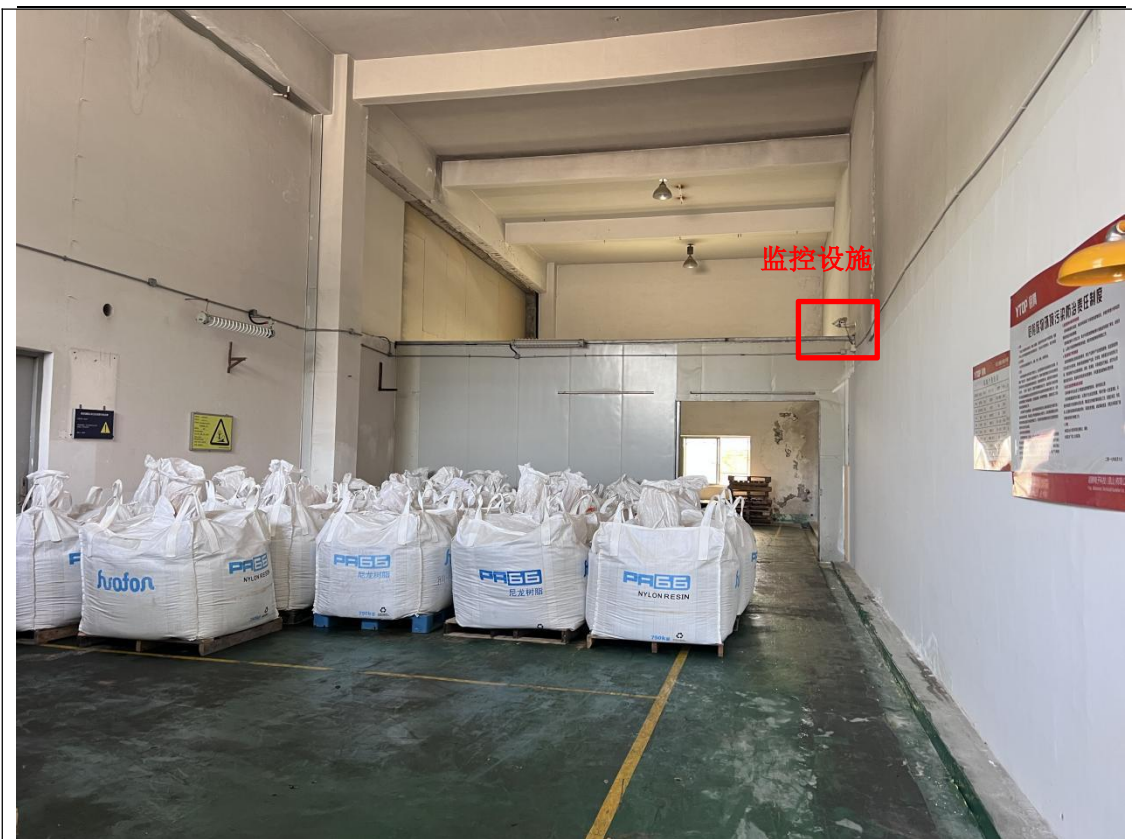
危险废物贮存设施内部情况及监控设施
