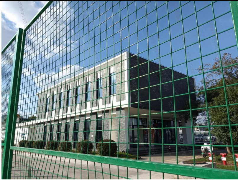
西侧物业楼照片
