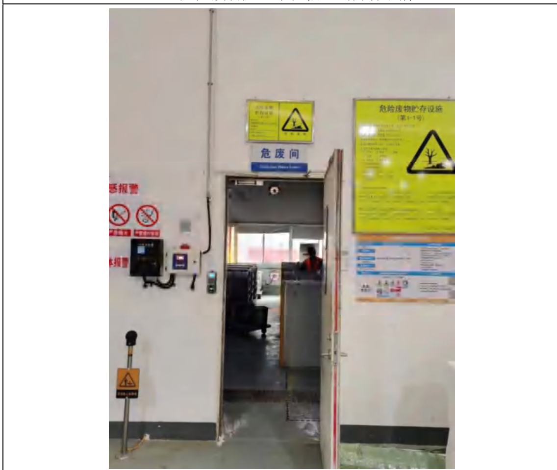
危险废物贮存设施标识牌
