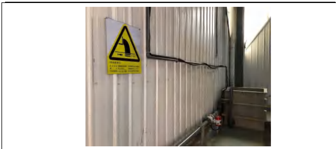
废水排口及标识牌
