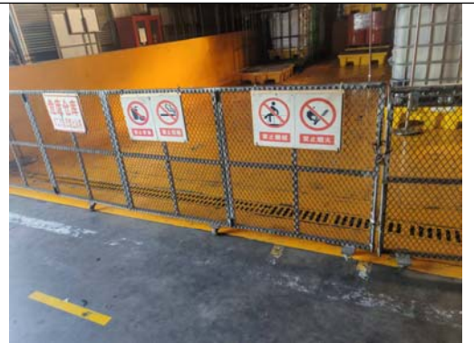
地面硬化及设置收集沟
