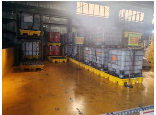
液体危废下方设置防泄漏托盘
