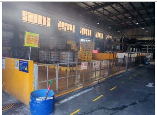
危险废物贮存设施全景
