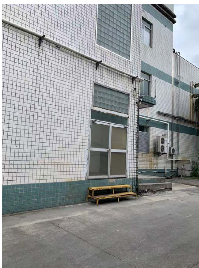
图 4.1-10 危废仓库监控
