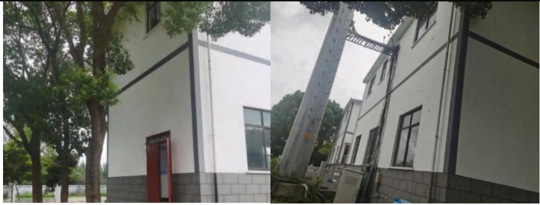
图 3-4 洞庭河站闸现状图
