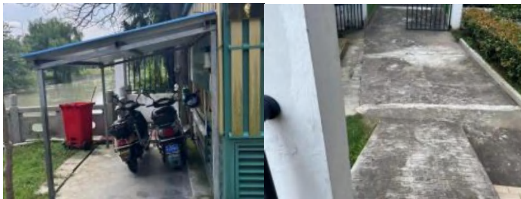
图 3-3 金鸡河站闸现状图
