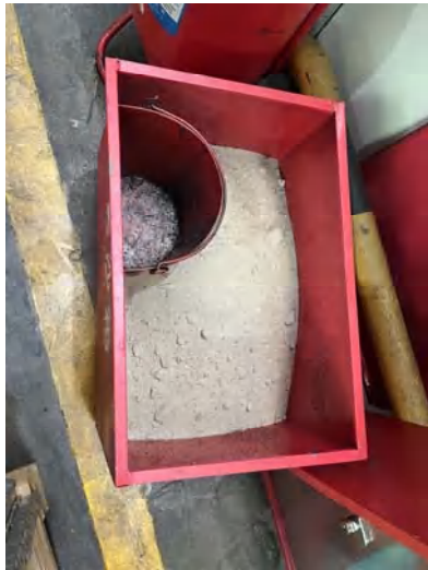
危废贮存设施外应急黄沙箱
