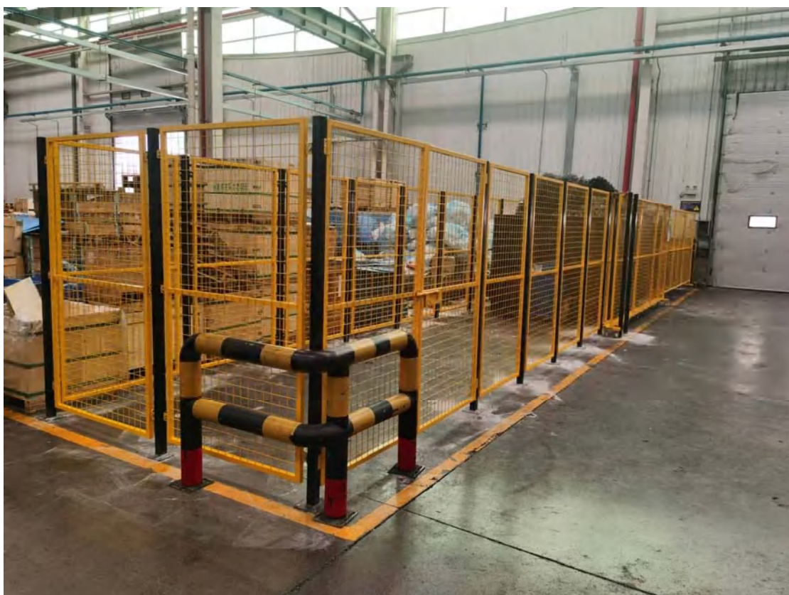
整改后的废金属屑堆场现状
