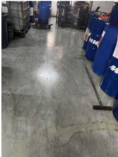
危废贮存设施现状
