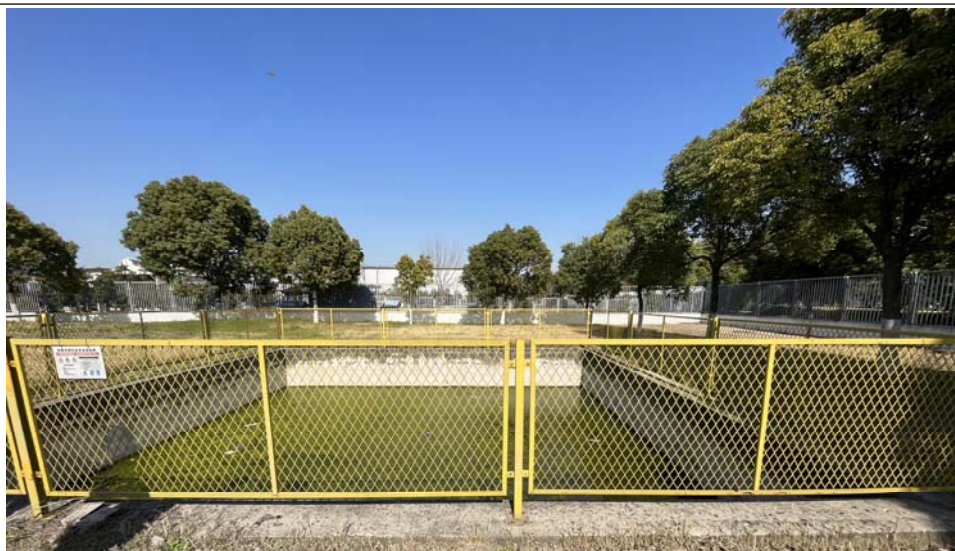
突发环境事故应急池
