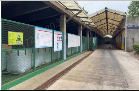
危险废物贮存设施（第 4-1 号）
