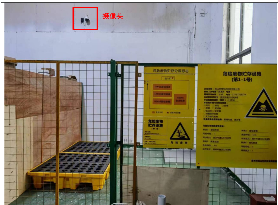
危险废物标识牌
