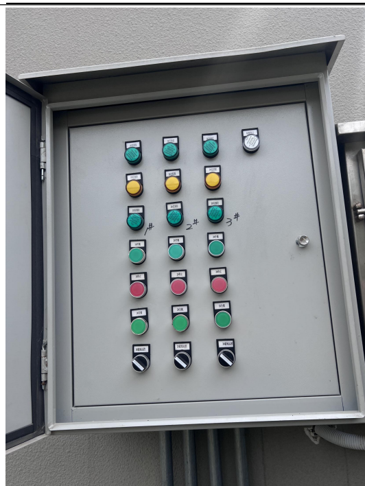
雨水闸阀控制电箱
