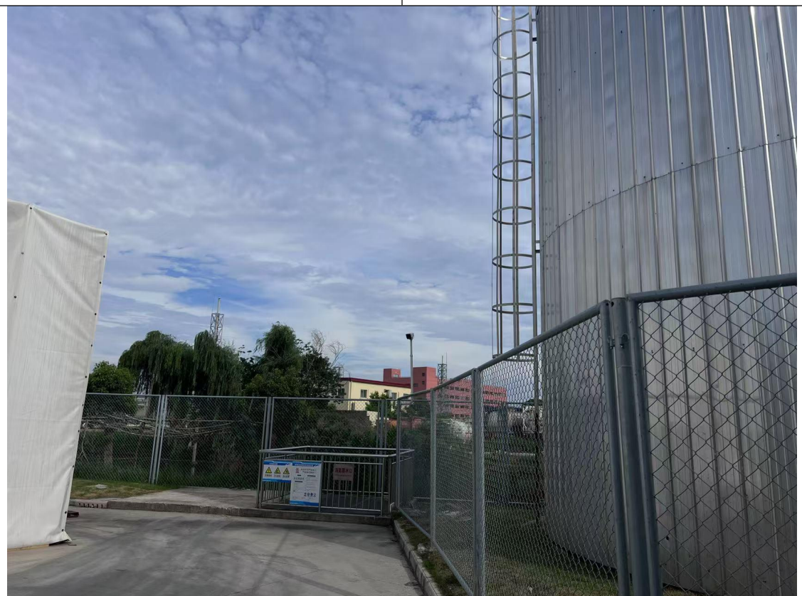
危废仓库外部监控
